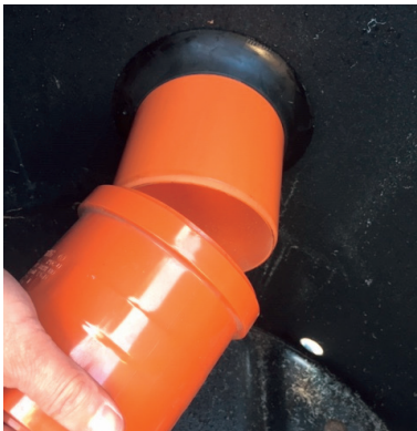
6. Doppelmuffe im Tank auf Spitzende stecken.
