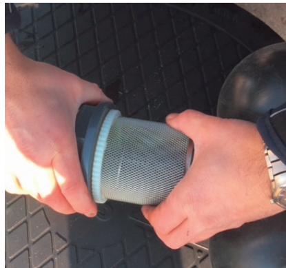
7. Edelstahlsieb von PVC-Mutter abschrauben.
