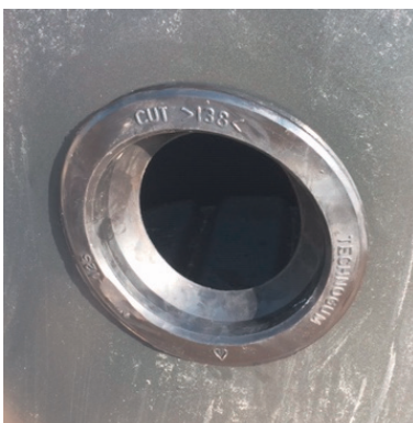
4. Zulaufdichtung in Bohrung stecken (Ansicht Tankaußenwand!).
