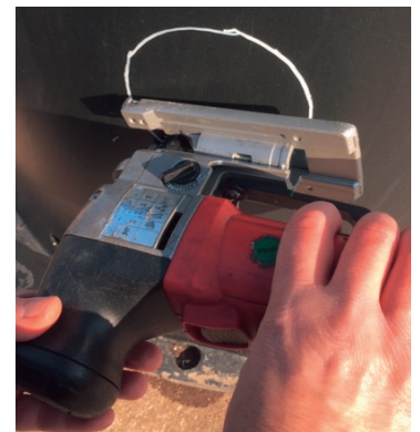
3. Bohrung mit Stichsäge ausschneiden.
