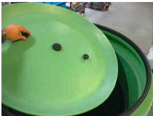
Schritt 19: Innenabdeckung in teleskopierbaren Domschacht stecken
