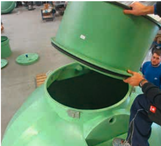
Schritt 11: Domschacht Aufsatz auf Trinkwassertank stecken. (Rundschnurdichtung sitzt zwischen Tank und Aufsatz!!)
