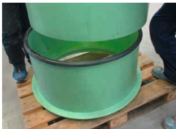
Schritt 5: Teleskopdomschacht vom Aufsatz her- unterziehen
