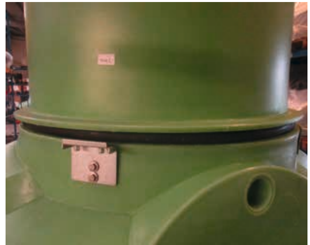
Schritt 12: Positionierter Domschacht Aufsatz
