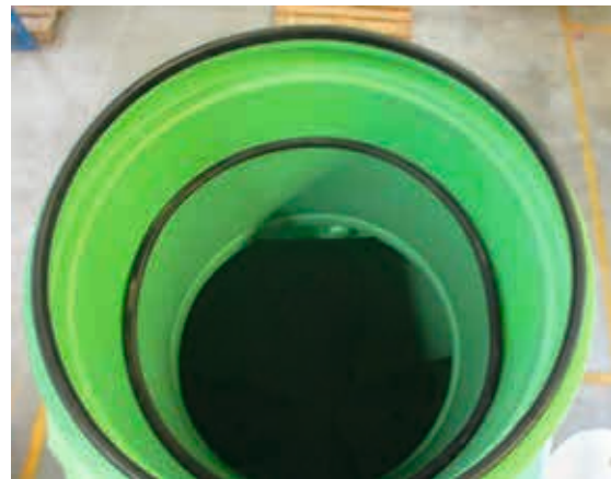
Schritt 18: aufgesteckter teleskopierbarer Domschacht
