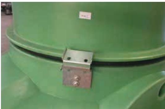
Schritt 13: Montagewinkel auf Domschacht Aufsatz positionieren
