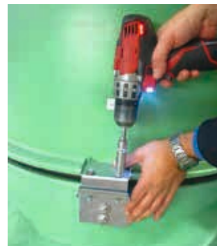
Schritt 14: Mittels Sechskantschrauben beide Montagewinkel miteinander verschrauben
