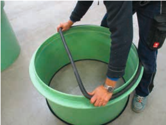
Schritt 7: Rundschnurdichtung auf Unterseite Domschacht Aufsatz stecken
